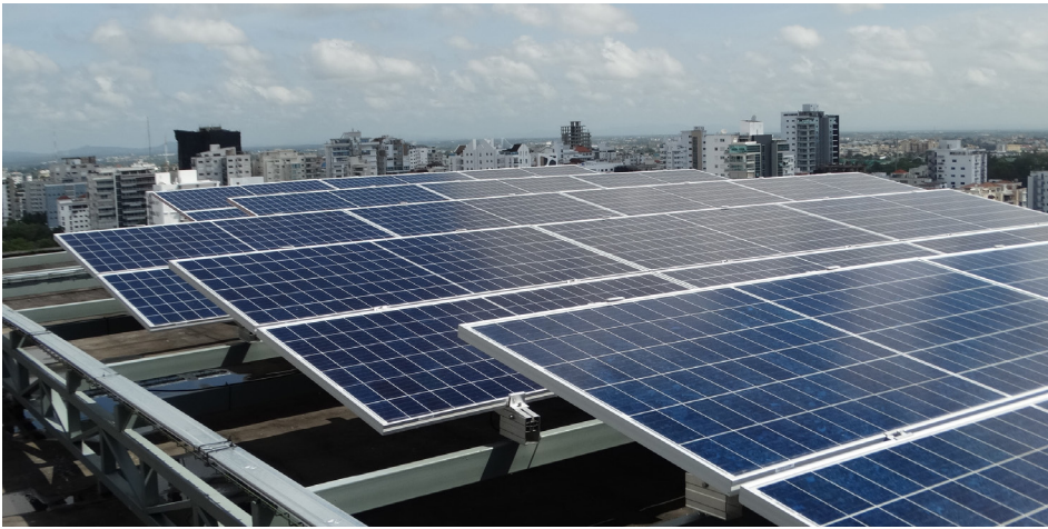
El proyecto cuenta con 106 paneles fotovoltaicos, para un suministro de energía de 37.52 kilovatios pico.
