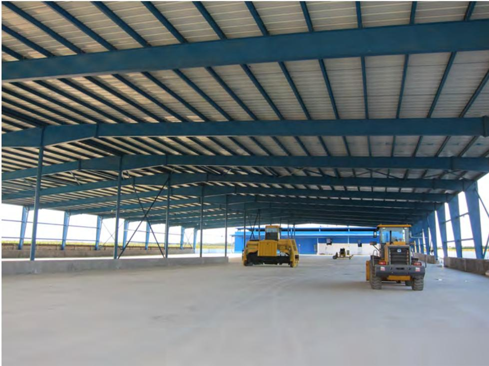
**Figura 10:** Área cubierta para el pre-tratamiento aeróbico de residuos sólidos con cargador de ruedas y máquina especial para volver los residuos, ejemplo de china (Zhao 2011)
