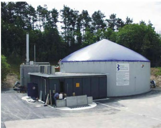
**Figura 15: Planta de biogás pequeña con cogeneración para la producción de electricidad y calor – ejemplo adecuado para complejos turísticos**
